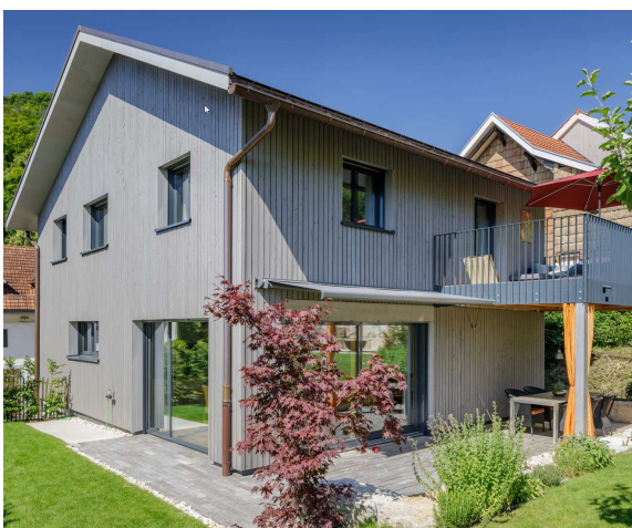
Abb. 3: Referenzbild Einfamilienhaus mit privaten Grünflächen (Hübscher Holzbau AG)
